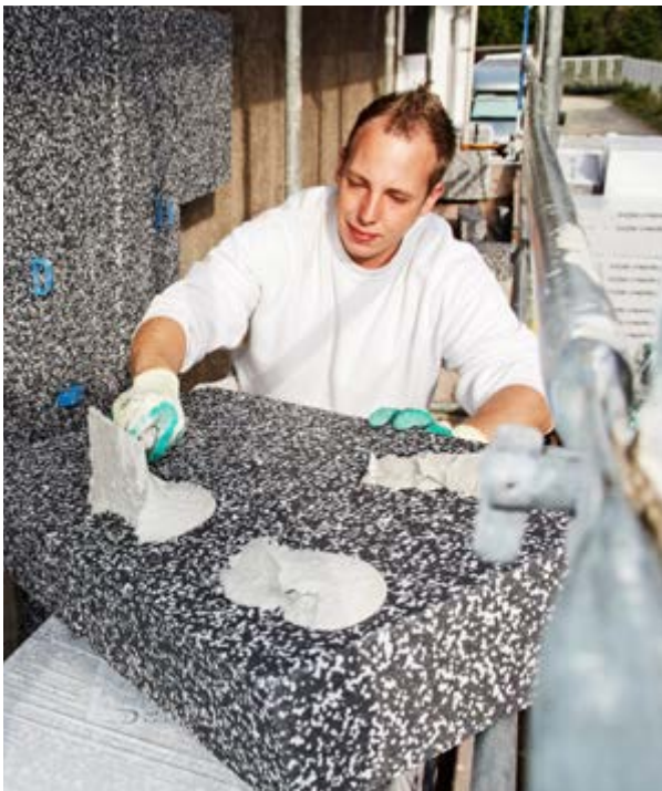
Anbringung einer Polystyrolplatte.
