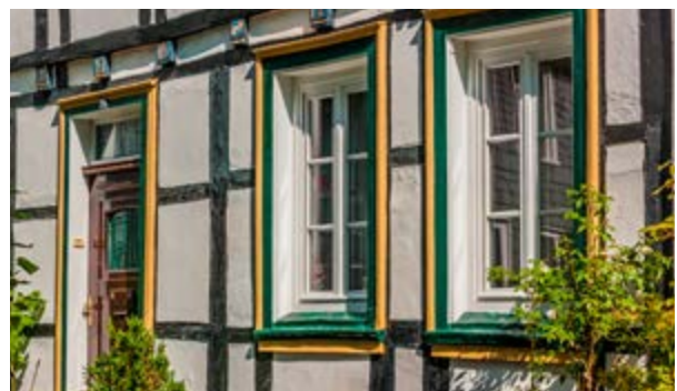
Für denkmalgeschützte Häuser kann Innendämmung eine Lösung sein.
