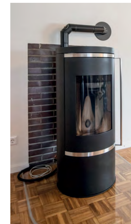
Als Reserve für strenge Winter gibt es den Holzpelletofen im Erdgeschoss. Im ersten Winter wurden nur zwei Pelletsäcke verbraucht.
