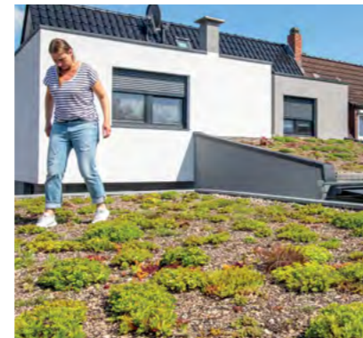
Neue Garage und neuer Anbau wurden sofort extensiv begrünt
