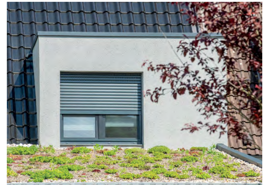
Vor dem Schlafzimmer im ersten Stock kann das Gründach an heißen Tagen Feuchtigkeit verdunsten und für eine kühlere Luft sorgen.
