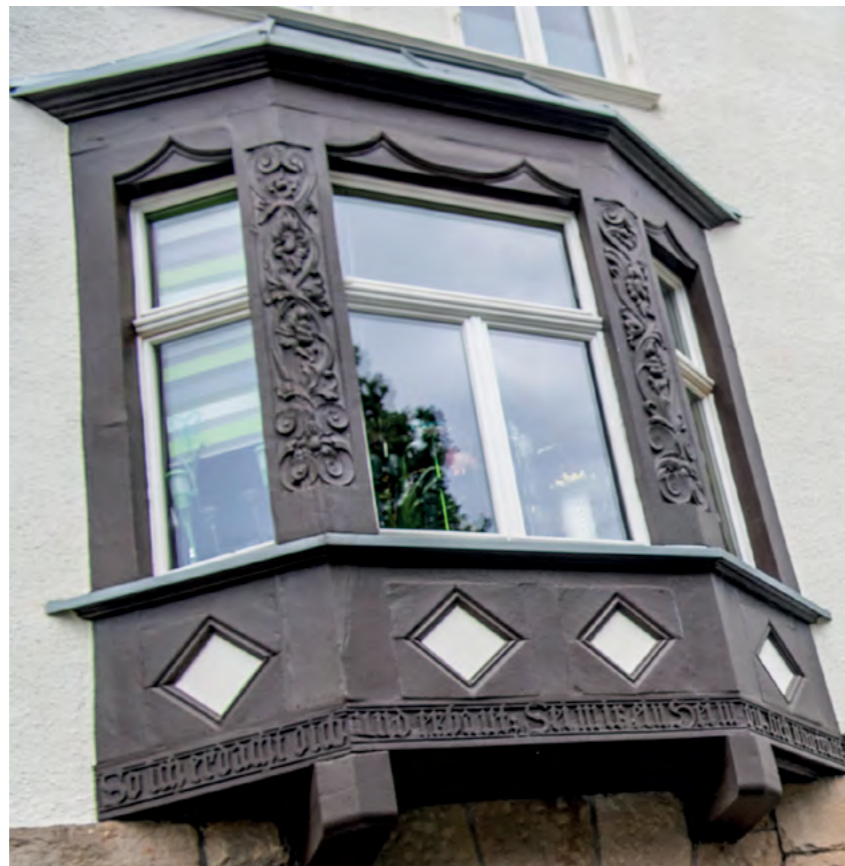
Das aufwändige Schnitzwerk des linken Holzerkers wurde sorgfältig saniert.
