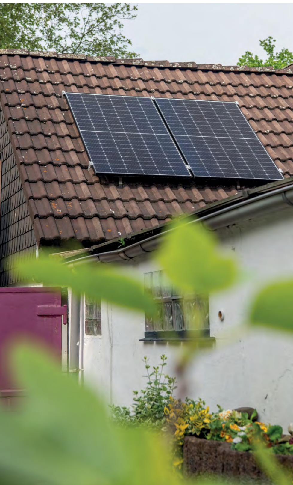
Schnell installiert: das Balkonkraftwerk auf dem Garagendach.
