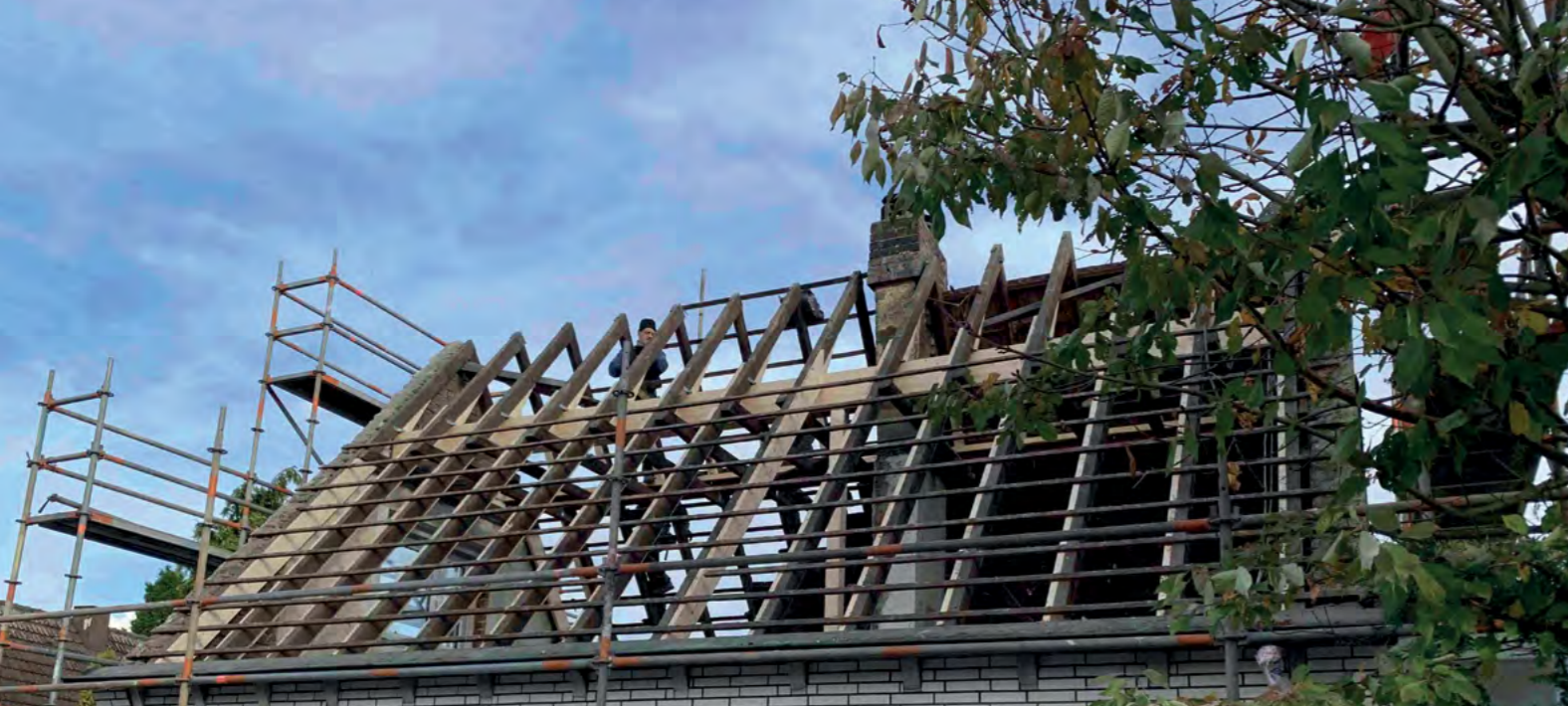
Für den Anschluss des Neubaus mussten zusätzliche Mittelpfetten im Dachstuhl ergänzt werden.
