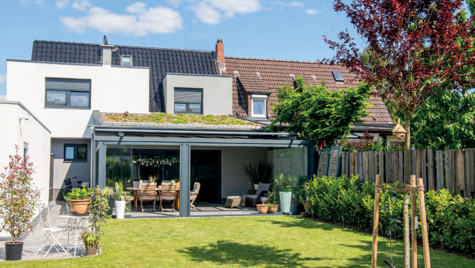
Garage (links) und Anbau mit Wintergarten wurden neu errichtet. Dabei konnte die Dachbelastung durch die Gründächer vom Architekten von vornherein gut mit eingeplant werden.
