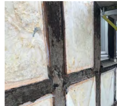
Beschichtete Balken und Füllungen
