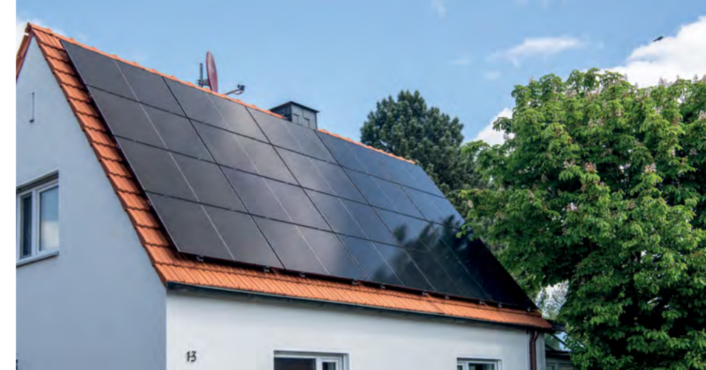
Für die Photovoltaikanlage wurde das Dach erneuert.
