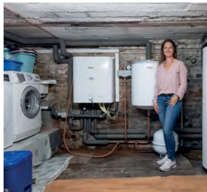
Ein Kohlenkeller wird zum sauberen Wärmepumpen-Heizungskeller
