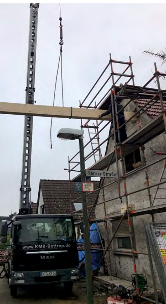
Die Mittelpfetten wurden mit einem Kran quer über die Straße aus waagrecht durch den Giebel in den Dachstuhl eingeschoben ( links ) und bilden den Anschluss für das Dach des Neubaus.
