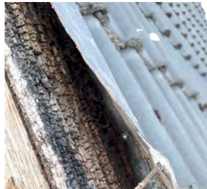
Verwitterte Dachanschlüsse
