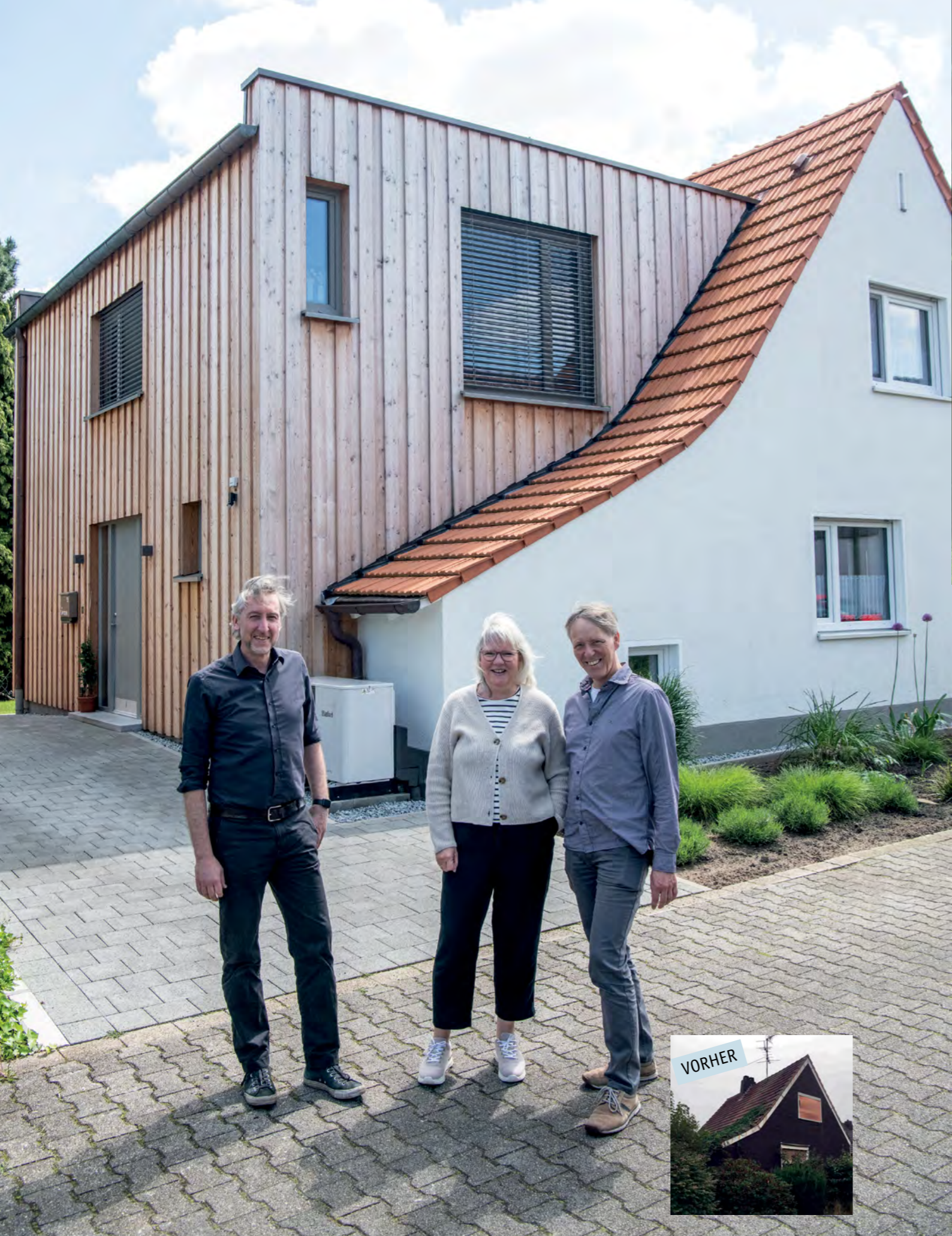
Der Neubau schmiegt sich versetzt an die charakterische Siedlungshausfassade. Architekt Martin Güldenberg, Sabine und Dr. Andreas Schmidt (von links) freuen sich über das gelungene Umbauprojekt.
