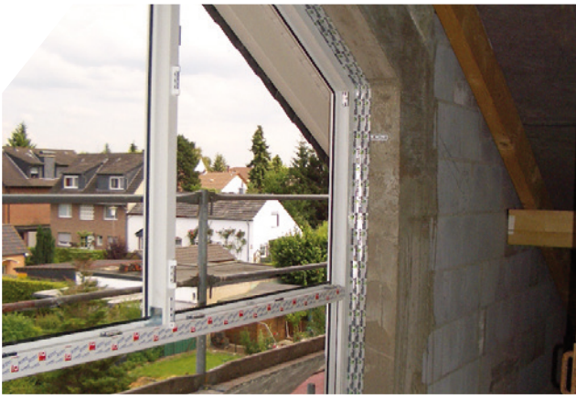
Luftdichter Anschluss eines Fensters mit Glattstrich des Mauerwerks.
