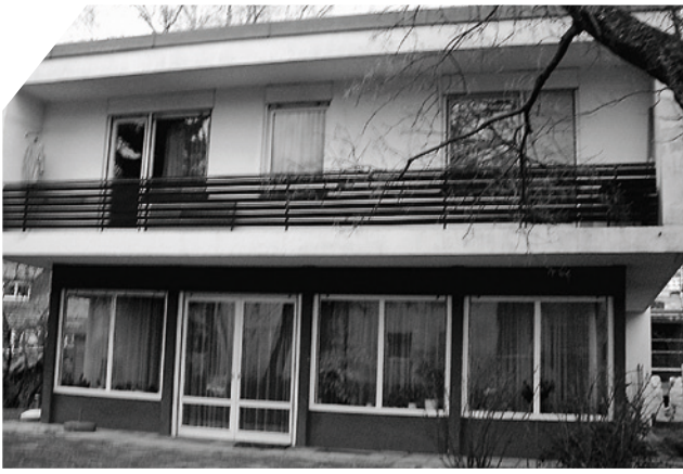
Vor und nach der Modernisierung
