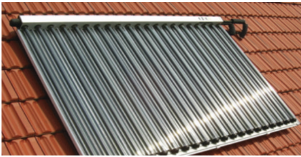
Vakuurröhrenkollektor zur Warmwasserbereitung
