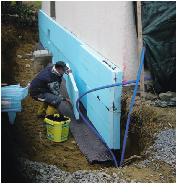
Die Perimeterdämmung wird angebracht
