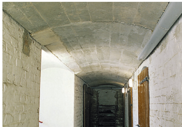
Steinwolle-Lamellen passen sich gut an das Gewölbe an
