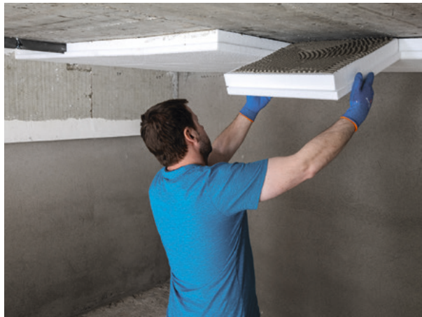
Dämmplatten aus Hartschaum mit Stufenfalz werden hier vollflächig an der Kellerdecke verklebt
