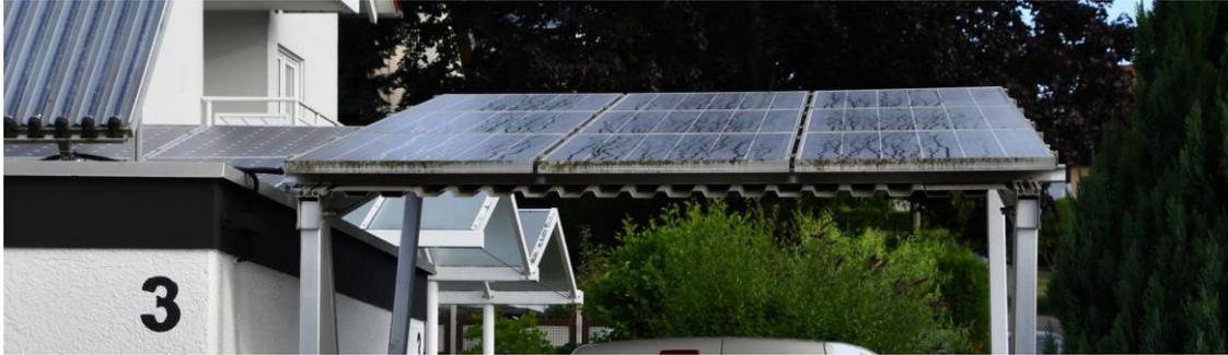
$$\frac{\text{Reichweite}}{\text{Jahr}} = \frac{900 \frac{\text{kWh}}{\text{kWp}} \times \text{Jahr} \times 3 \times 6 \text{m}^2}{\frac{20 \text{kWh}}{100 \text{km}} \times 6 \frac{\text{m}^2}{\text{kWp}}} = 13.500 \frac{\text{km}}{\text{Jahr}}$$
