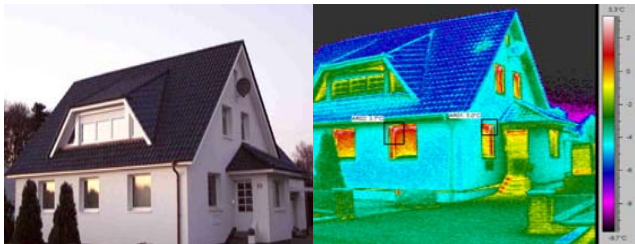
Das gleiche Haus, nachdem gezielte Sanierungs- und Dämmungsmaßnahmen ausgeführt wurden. Erkannt durch Infrarot-Thermografie.
