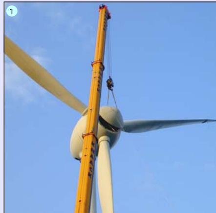
1./2. Montage von Kopf und Rotor
