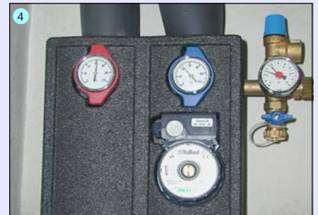
Fotos: Stadt Remscheid, Gebäudemanagement
