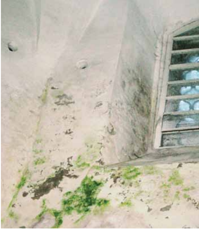
Sergieva-Klosterkirche, Handstützwand von innen gesehen, vor Einbau der Isophob-K-Flächensperre. Textquelle und Fotos: Hydro Chemie INT GmbH, Oer-Erkenschwick.
