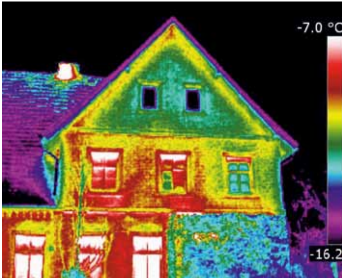
Älteres, nicht saniertes Einfamilienhaus im Münsterland. Fotos: A. Elsbecker
