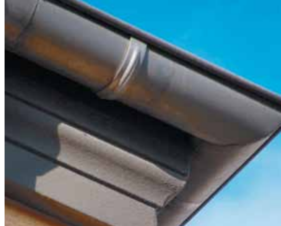
Charakterische Elemente – wie unten die Fensterbänke – wurden aus Polystyrol originalgetreu nachgebildet.
