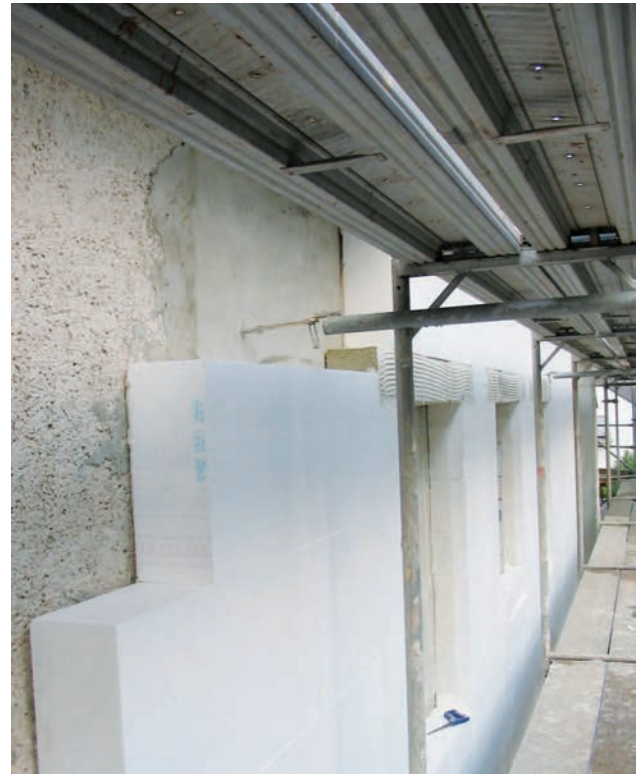
Bild 28: Wärmedämmverbundsystem mit Polystyrol
