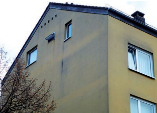
Bild 15 – 18: Algen gibt es auch auf ungedämmten Fassaden
