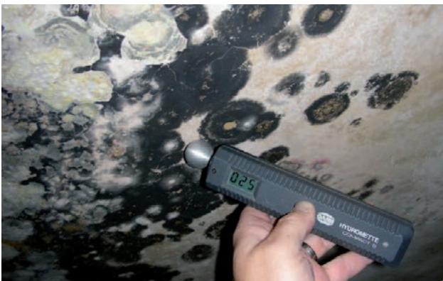
Bild 1 – 2: Typische Schimmelschäden
