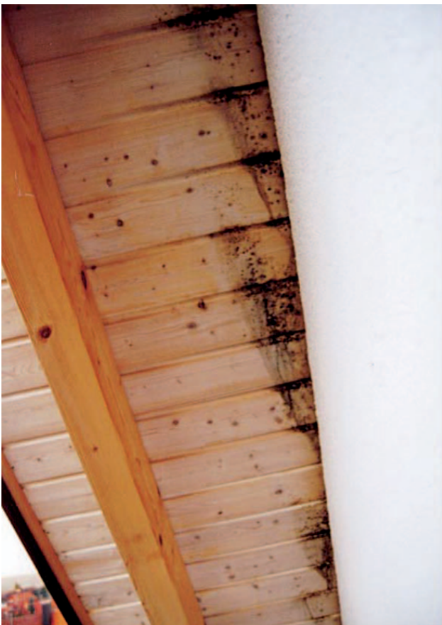
Bild 9: Dachüberstand außen an der Dachwohnung
