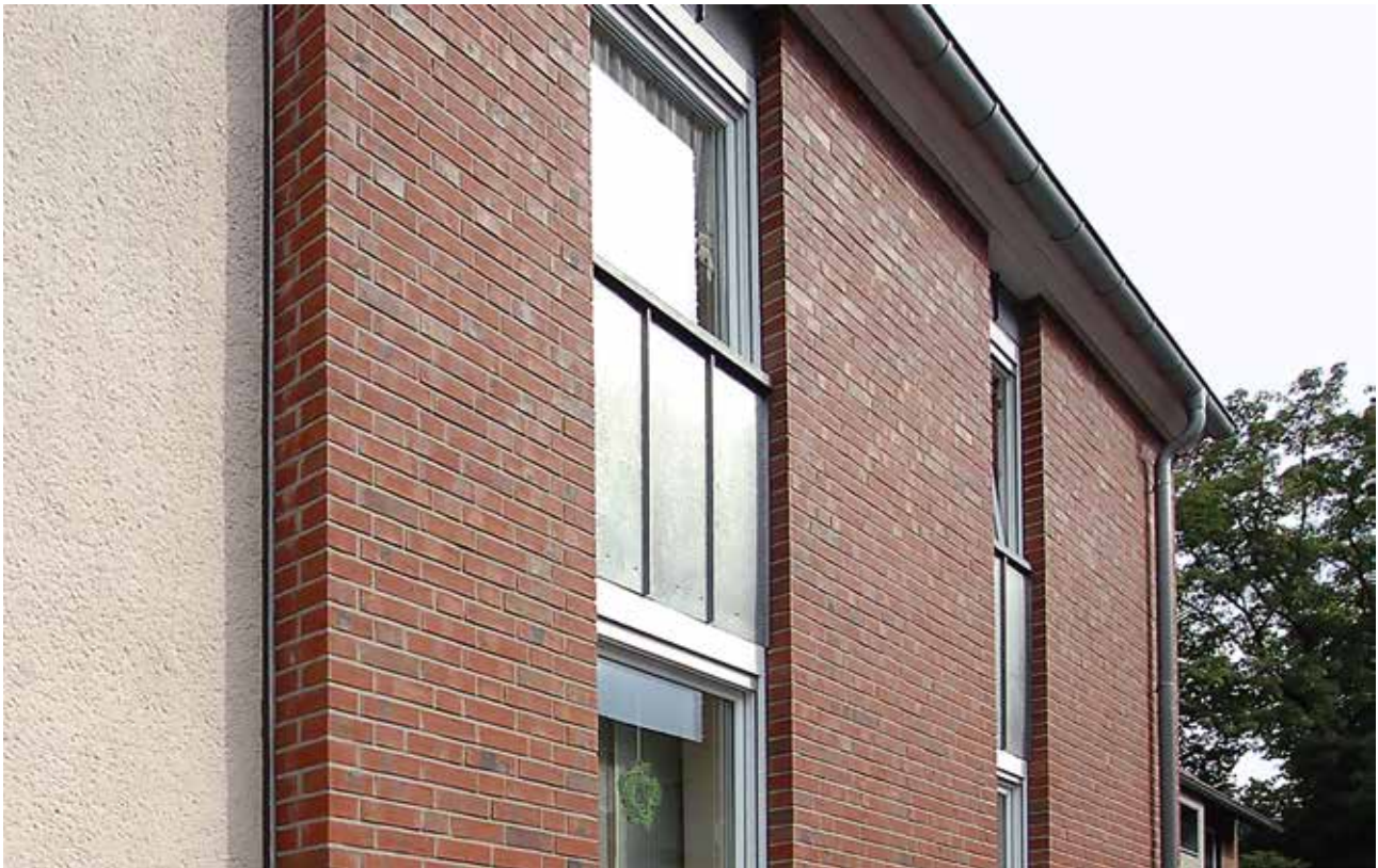
Fassadendämmung und Vollstein-Klinker-Verkleidung bilden eine wartungsfreie und wertstabile Lösung.
