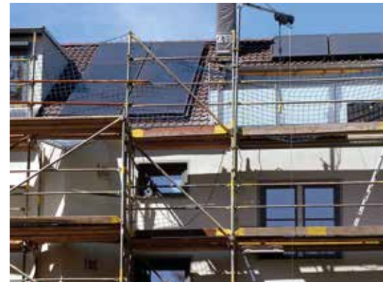
Flachkollektoren liefern Wärme von der Sonne.
