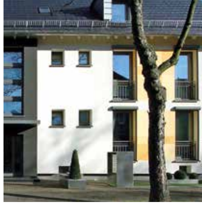
Erfolgskonzept: Mit der Modernisierung die Vermietbarkeit optimal sichern.
