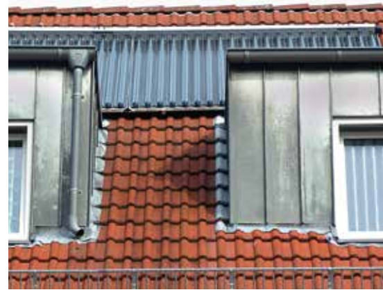
Röhrenkollektoren unterstützen das Heizungssystem.
