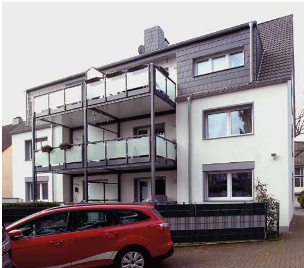
Statt kleiner Balkone schmückt das Haus jetzt eine großzügige Vorsatzkonstruktion, ohne Kältebrücken und Energieverluste.
