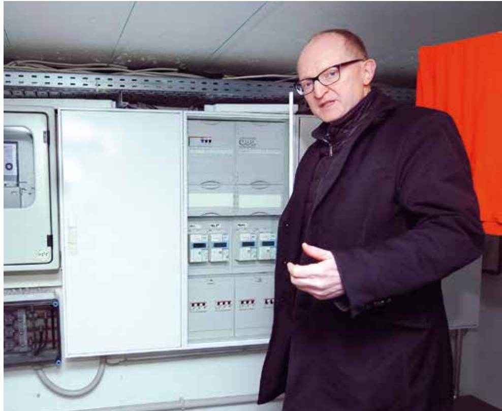
Auch die Elektroinstallationen wurden im Zuge der Baumaßnahmen erneuert.
