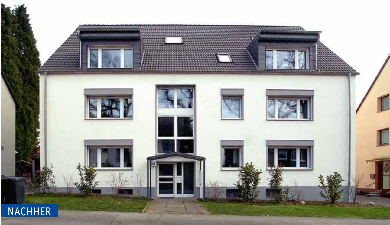
Ein modernes Äußeres trifft hier auf ausgefeilte Heiztechnik und eine energetische Sanierung.
